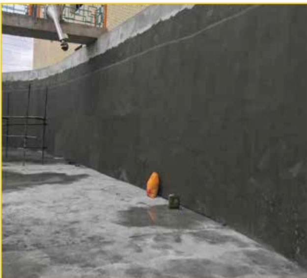
Vand Waterproof Coating-A، پوشش دهنده آب بند آماده به مصرف - دو جزئی، ترکیبی از دیسپرسیون کوپلیمری بر پایه اکریلیک با خاصیت انعطاف پذیری بالا و مواد پایه سیمانی می باشد که مخصوص آب بندی و تعمیرات آب بند سازه های بتنی نگهداری مایعات (مخازن آب، استخر، تصفیه خانه های آب و فاضلاب)، پشت بام، سرویس ها، چاله های آسانسور و ... در ضخامتهای کم می باشد.
